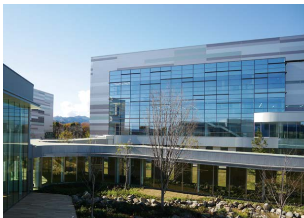
新セントラルラボ：検査ラボ棟（左奥）とR&D棟（右）
